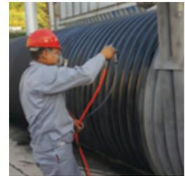
Hi-Coat 840-M als Beschichtung für industriellen Wärmetauscher.
